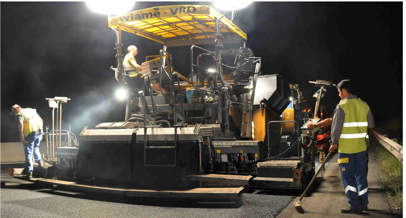
Travaux d'application d'enrobés sur l'autoroute A4 en 2009
